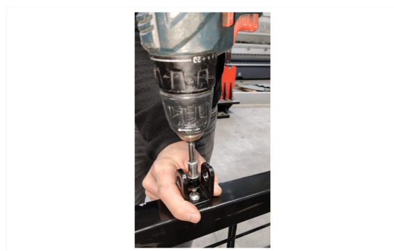
Fot. 3. Dokręcanie śruby M8 w uchu zawiasowym.
